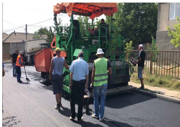
Imaginea 5. Lucrări de reparație a drumului
