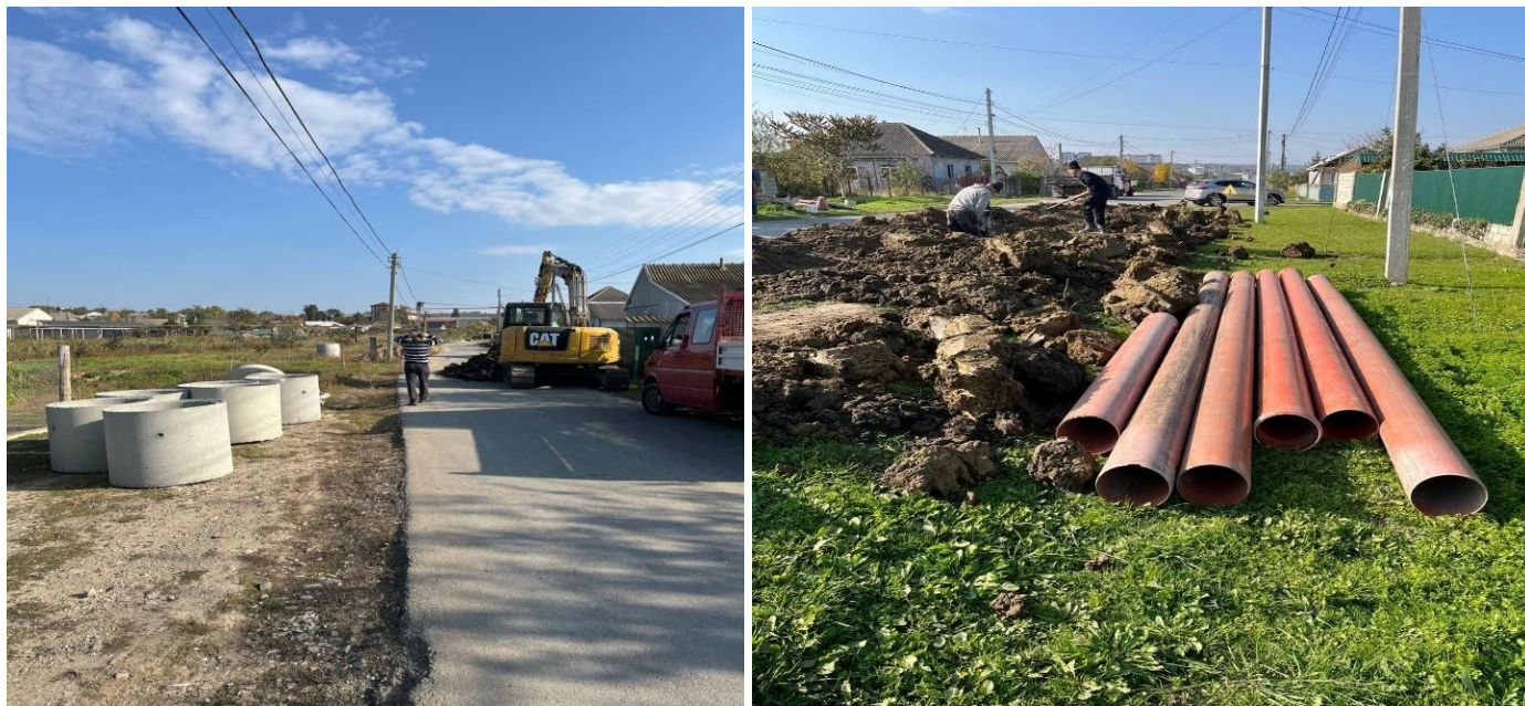
Imaginea 4, 5. Proiect „Construcția rețelelor de canalizare în cartierul Zayalpujie din mun. Comrat”
