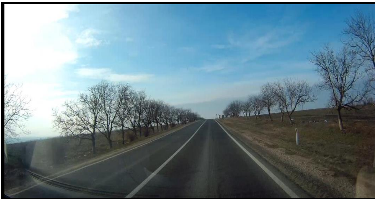
Покрывтие в отличном состоянии (М3 Кишинэу – Комрат – Джурджулешть – гр. Румынии, км 74)
