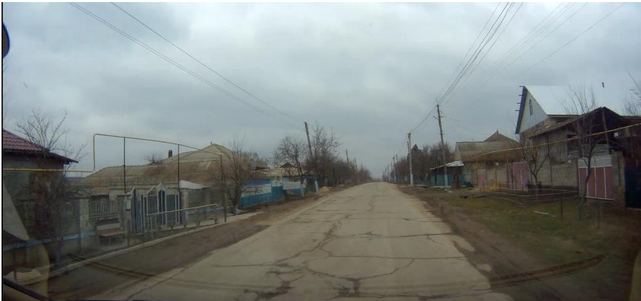
Покрытие в удовлетворительном состоянии (L 627.1 Подъезд к с. Бешгиоз. км 2,2)
