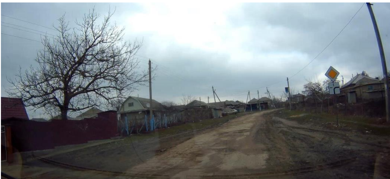
Покрытие в очень плохом состоянии (L 627.1 R29-подъезд к с Джолтай км 7,5)
