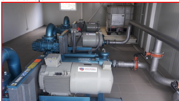
Foto 13: Stație de suflante în cadrul stației de epurare din or. Vulcănești
