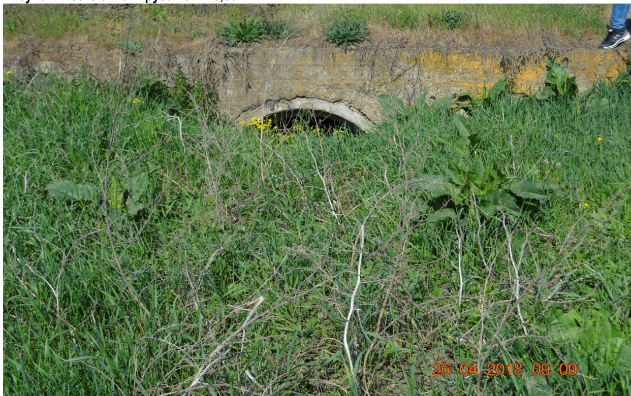
Рисунок 1: Заиленная труба на км 3,50
