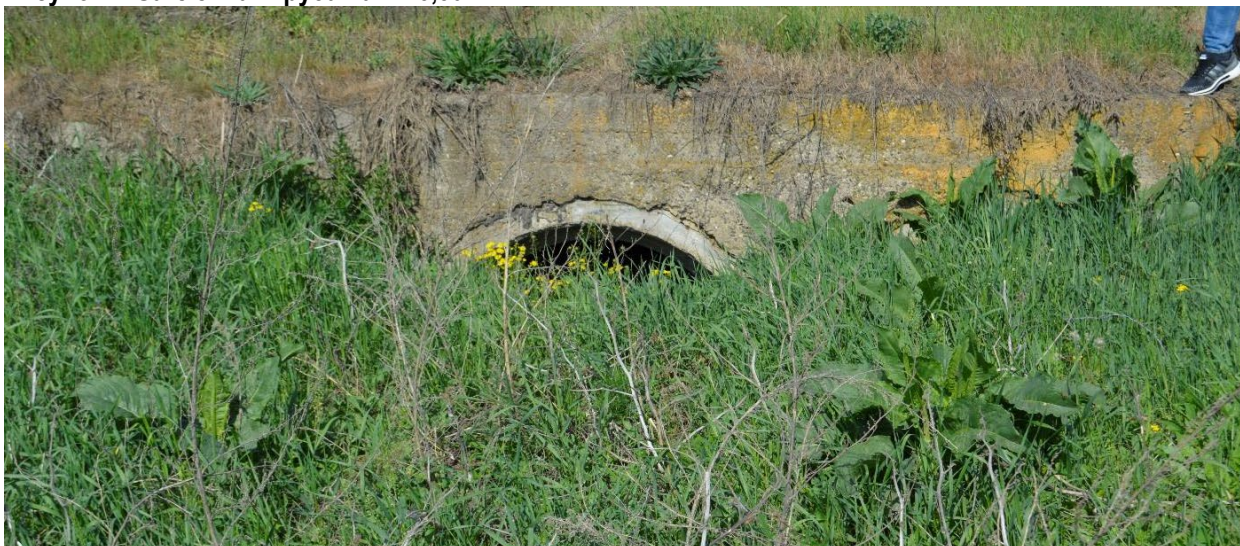
Рисунок 2. Заиленная труба на км 3,50
