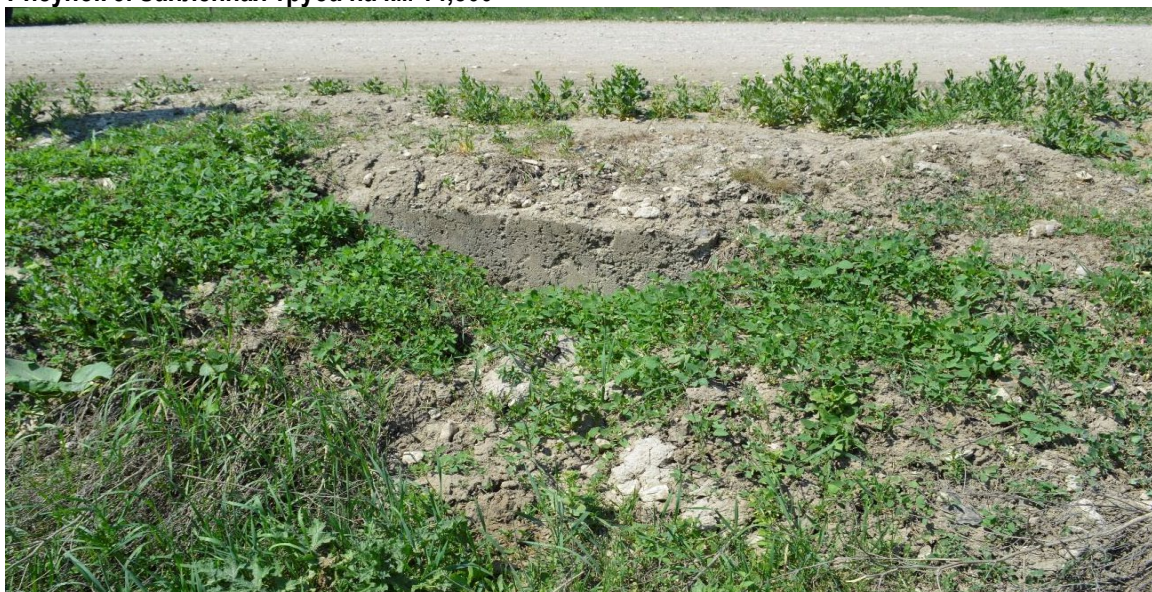
Рисунок 3. Заиленная труба на км 14,800
