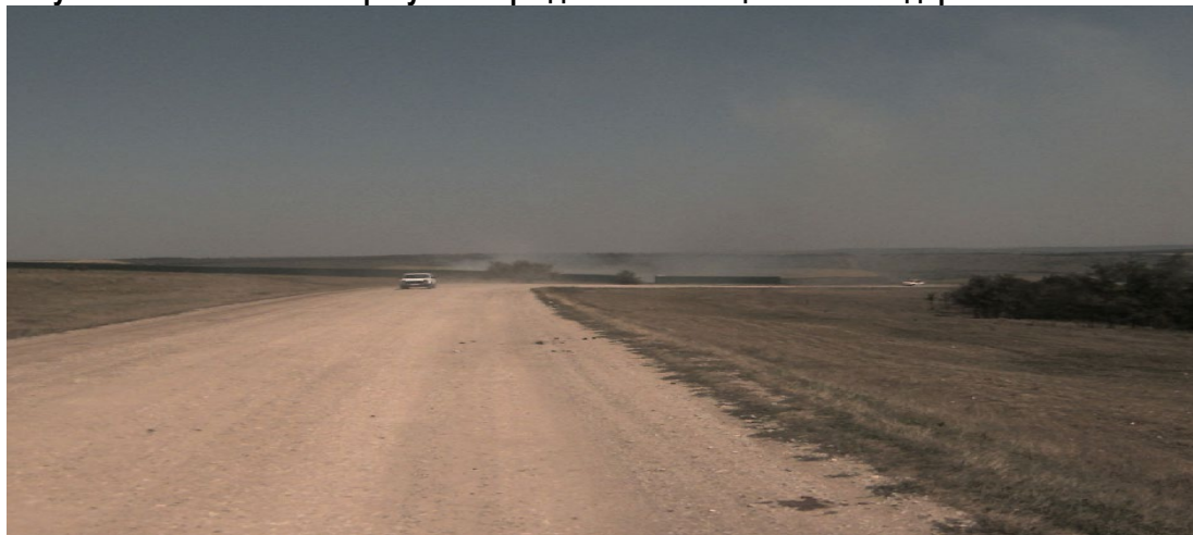
Рисунок 2. Облака пыли образуются при движении по щебеночным дорогам.
