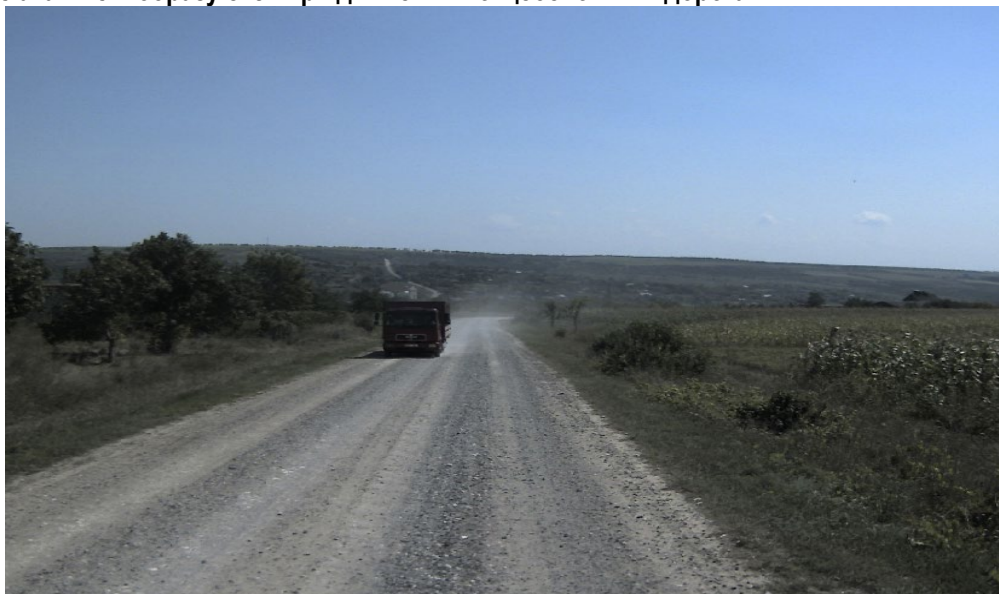
Рисунок 2. Облака пыли образуются при движении по щебеночным дорогам
